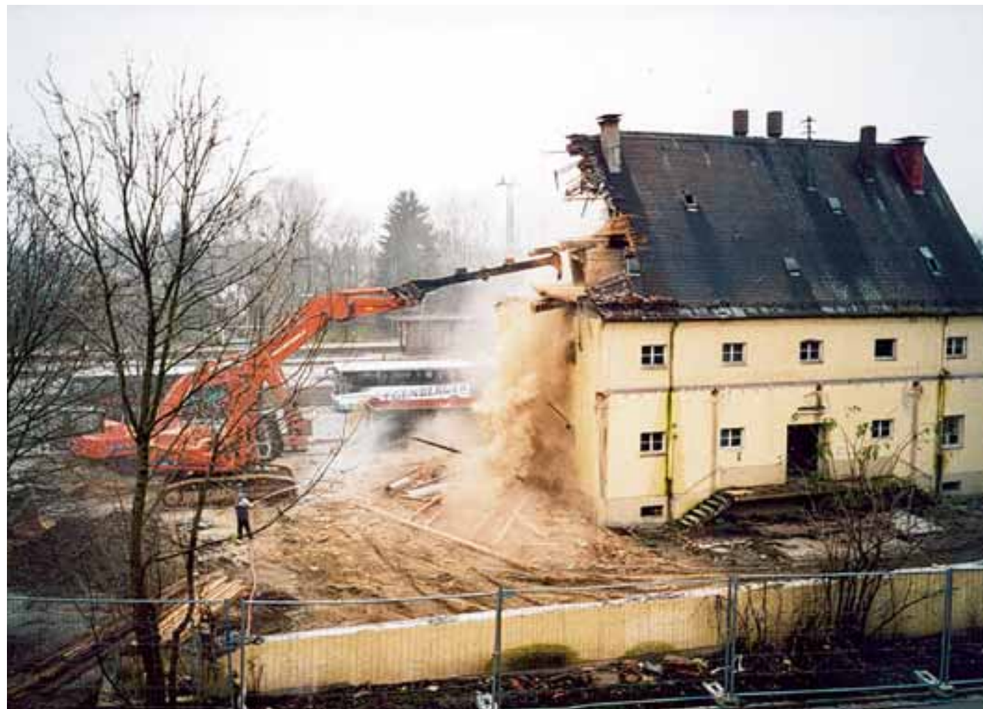
Im Jahr 2002 war die Firma für den Abriss des alten BayWa-Gebäudes und anschließend für die Schadstoffentsorgung verantwortlich. Das neue BayWa-Gelände ist jetzt in der Unterberger Straße 9-11 zu finden. Foto: privat
